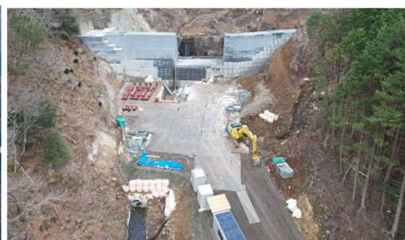
まちざわがわ 松沢川第2砂防堰堤
