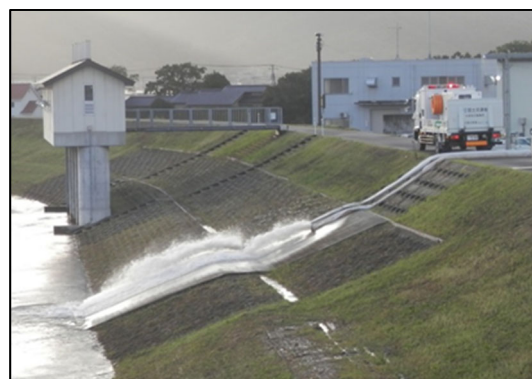
近年の排水ポンプ車稼動実績 (H29: 台風21号(函南町新田地区))
