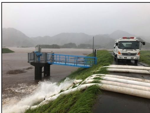
近年の排水ポンプ車稼動実績 (R1: 令和元年東日本台風(三島市御園地区))
