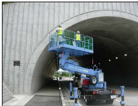
高所作業車によるトンネル点検
