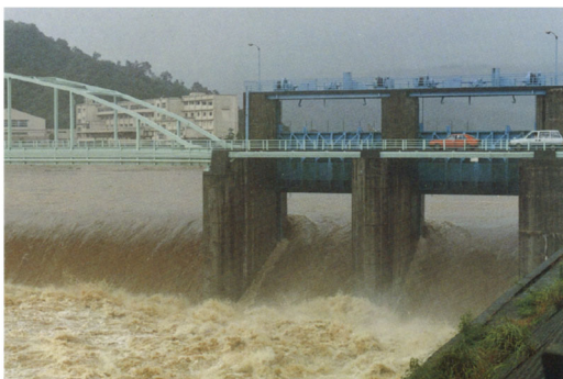
放水路分流堰の放流状況
