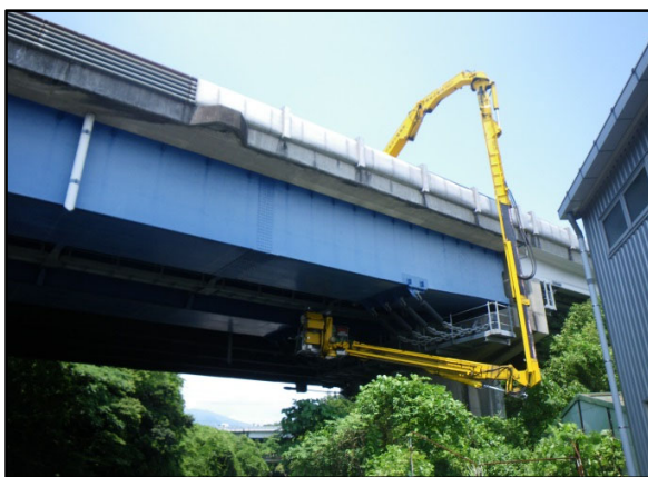
橋梁点検車による点検
