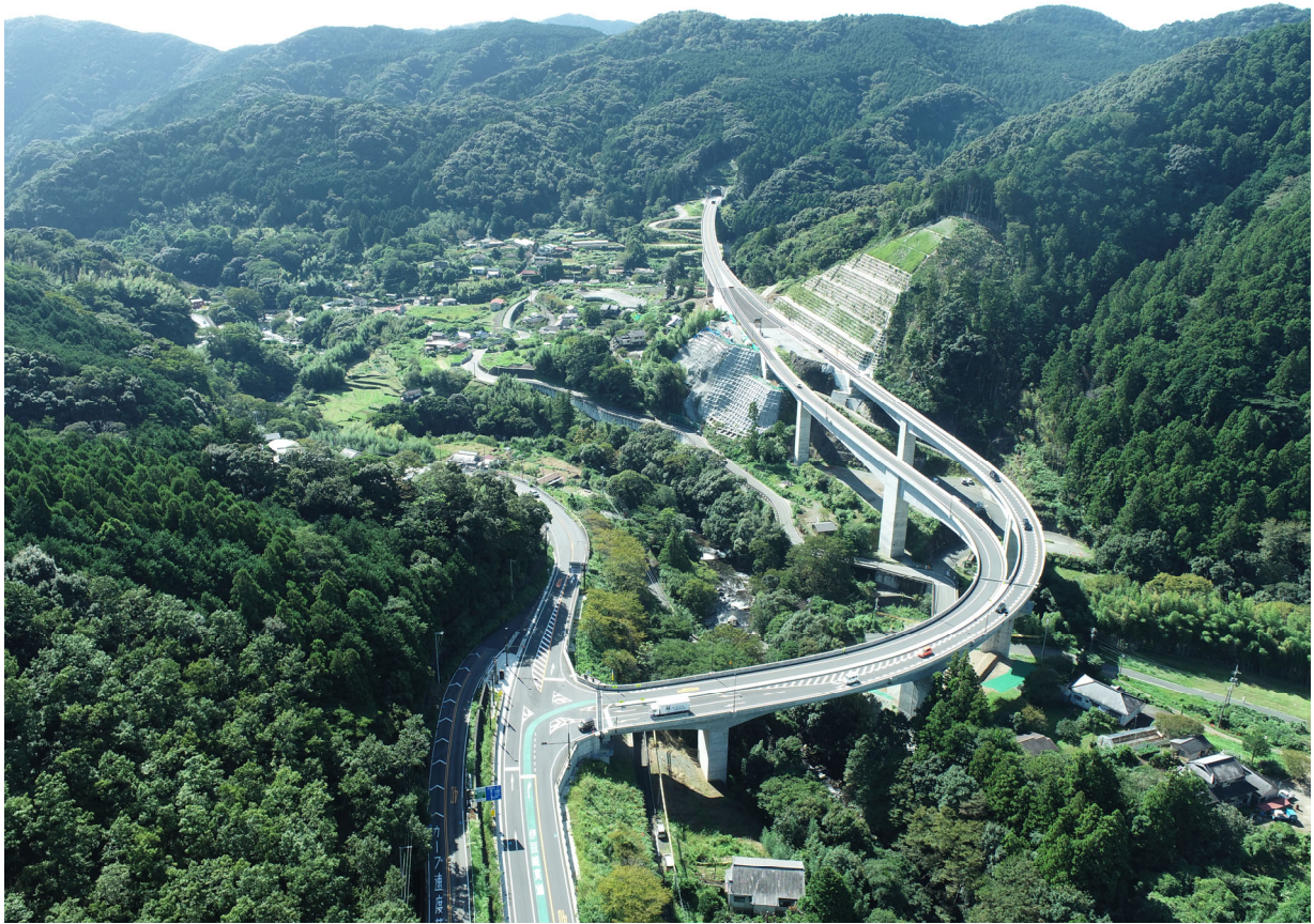
河津下田道路
