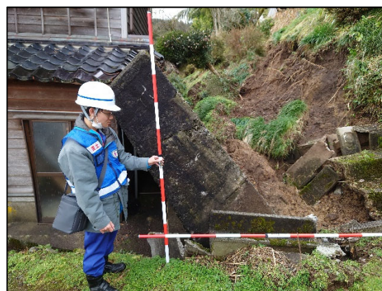
現地調査の様子(令和6年能登半島地震)
