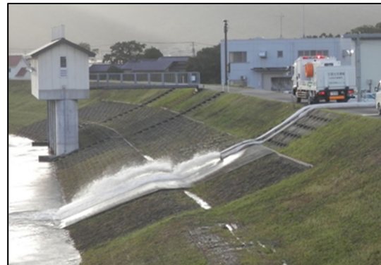
近年の排水ポンプ車稼動実績
