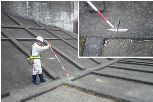
河川管理施設の点検 (護岸ひび割れ状況の確認)
