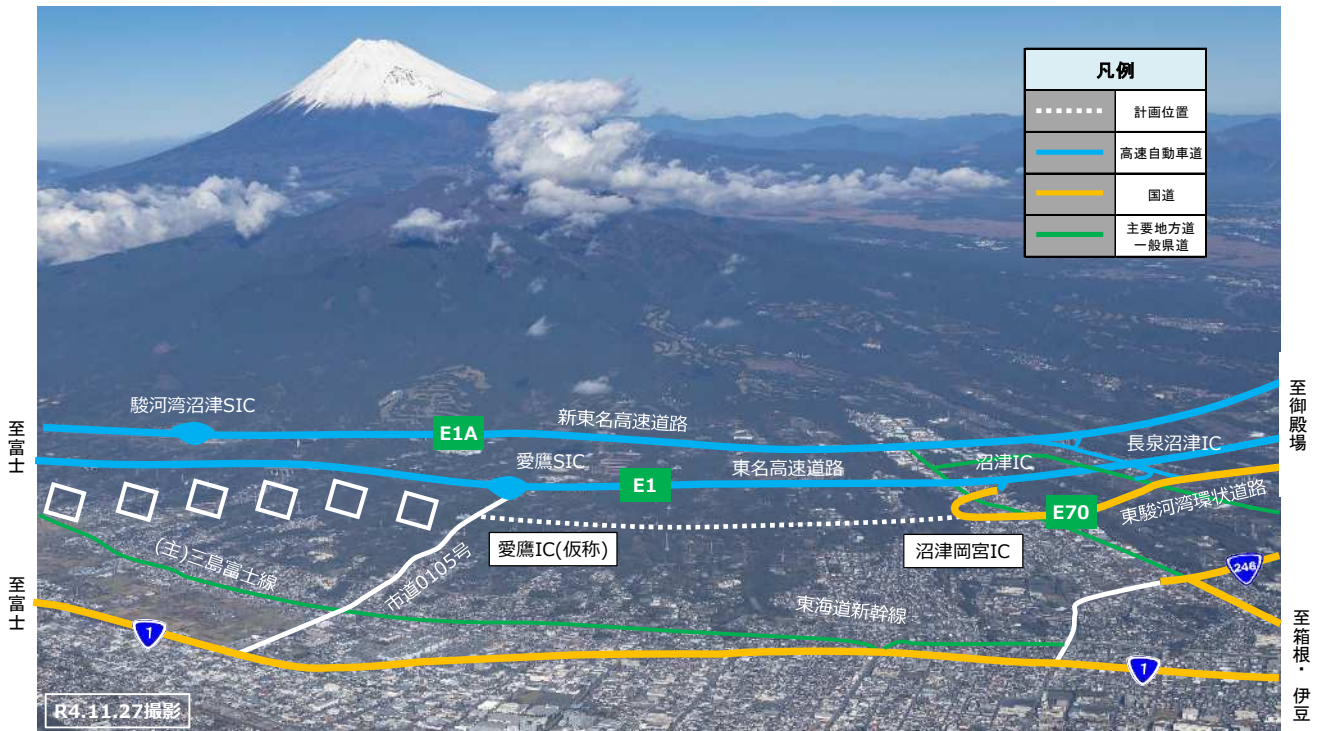
国道1号 東駿河湾環状道路（沼津岡宮IC～愛鷹IC（仮称））の状況写真
