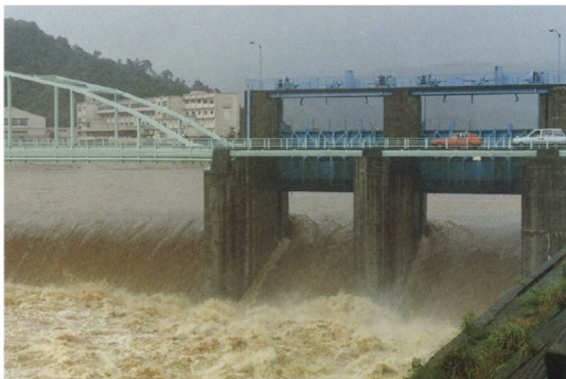
放水路分流堰の放流状況
