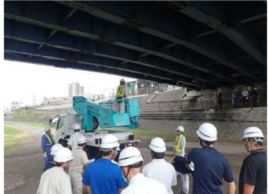
自治体向け橋梁点検研修(現地実習)
