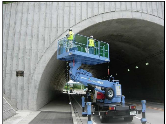
高所作業車によるトンネル点検
