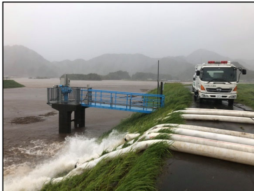
近年の排水ポンプ車稼動実績
