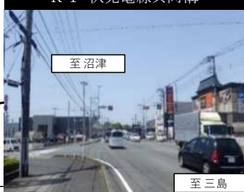
R 1 伏見電線共同溝
