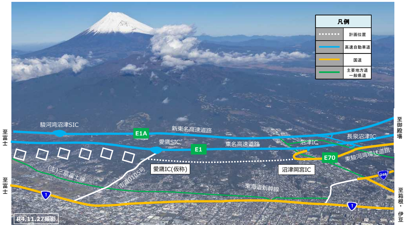
国道1号 東駿河湾環状道路 (沼津岡宮IC～愛鷹IC (仮称)) の状況写真
