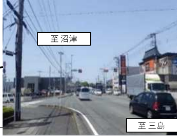
R 1 伏見電線共同溝
