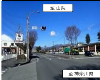
R 138 萩原電線共同溝
