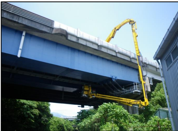
橋梁点検車による点検
