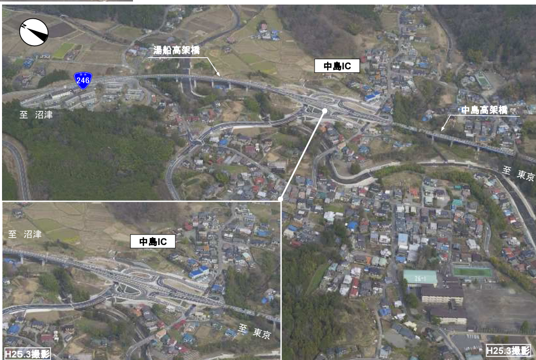
道246号 裾野バイパス（中島IC付近）の状況写真
