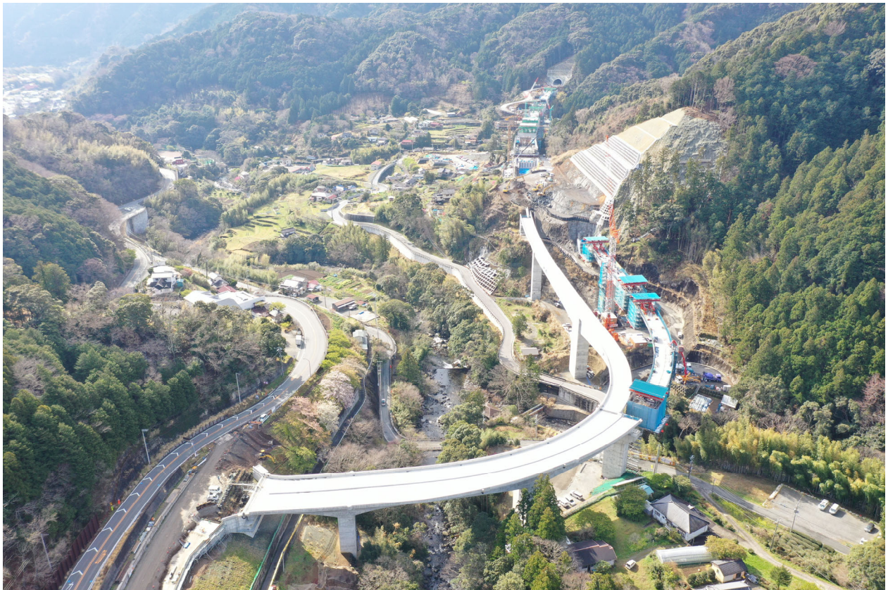
河津 IC(仮称)付近から下田方面を望む
