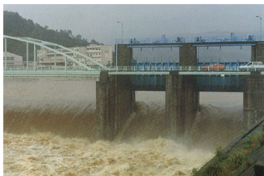
放水路分流堰の放流状況
