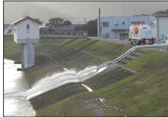
近年の排水ポンプ車稼動実績
