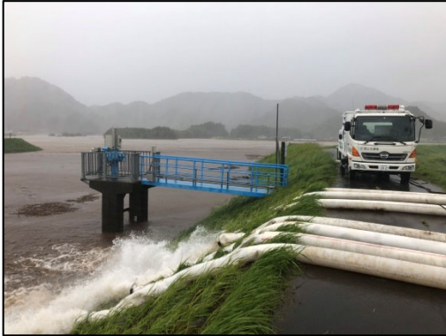
近年の排水ポンプ車稼動実績
