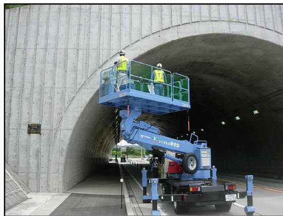
高所作業車によるトンネル点検
