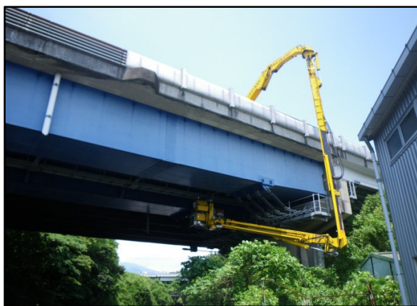
橋梁点検車による点検
