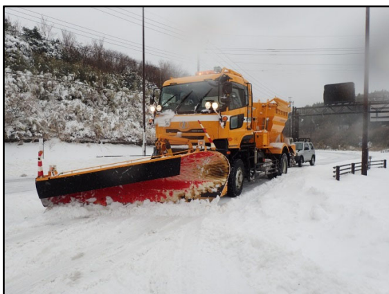
除雪作業(国道1号)
