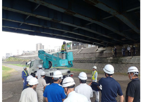
自治体向け橋梁点検研修(現地実習)
