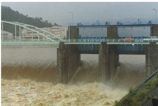
放水路分流堰の放流状況
