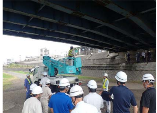
自治体向け橋梁点検研修(現地実習)
