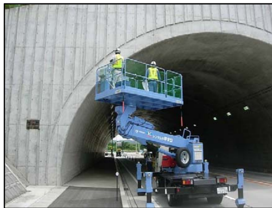
高所作業車によるトンネル点検
