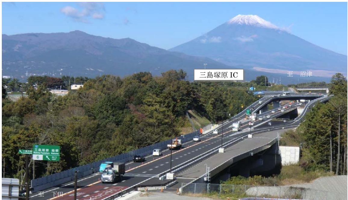
国道1号 東駿河湾環状道路の状況写真
