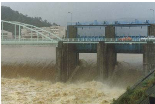
放水路分流堰の放流状況
