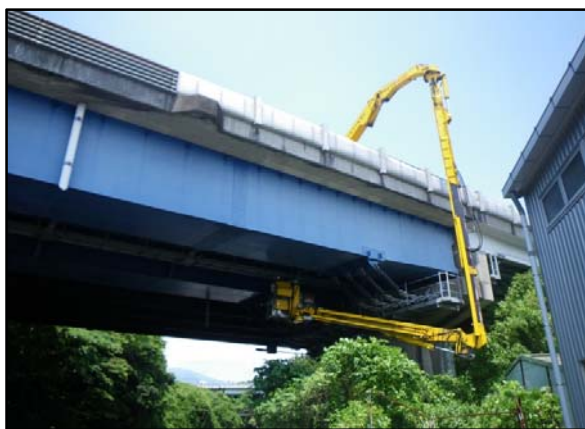
橋梁点検車による点検
