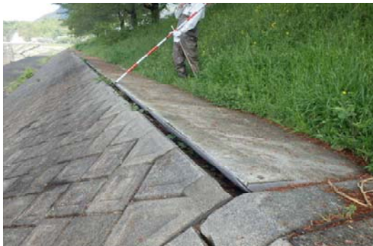
河川の巡視 (タブレット端末を活用した巡視状況登録)
