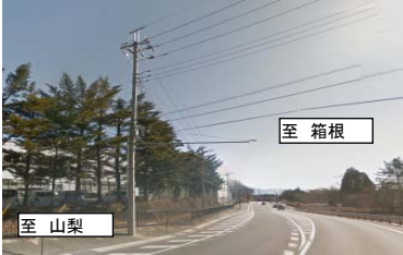
R1 38 須走電線共同溝
