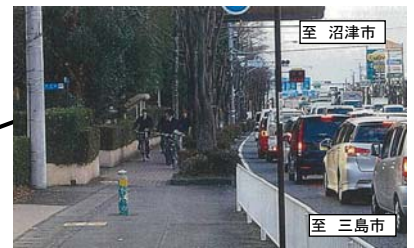
R1 柿田川地区歩道区間改良
