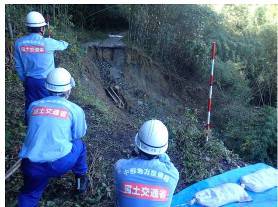
現地調査の様子(R1: 令和元年台風19号)
