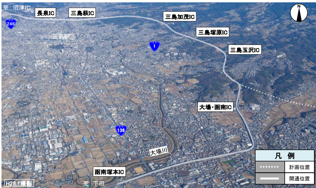
国道1号 東駿河湾環状道路の状況写真
