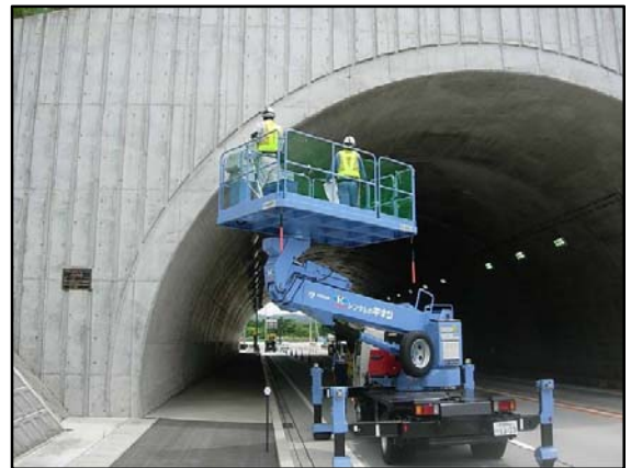
高所作業車によるトンネル点検
