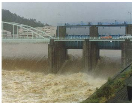
放水路分流堰の放流状況
