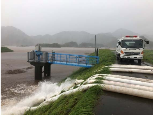
近年の排水ポンプ車稼働実績 (R1: 台風19号(三島市御園地区))
