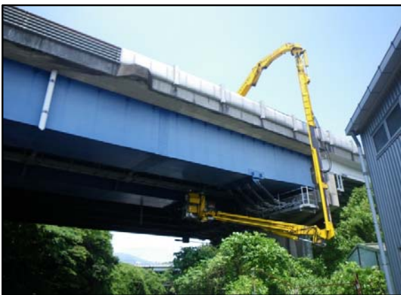
橋梁点検車による点検
