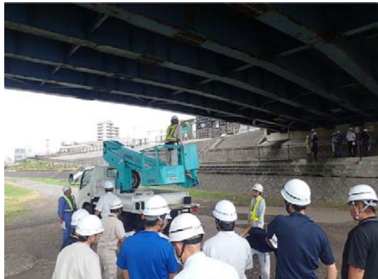
自治体向け橋梁点検研修(現地実習)
