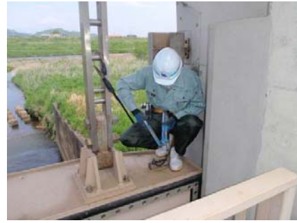
樋管ゲートの点検
