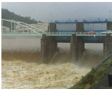
放水路分流堰の放流状況
