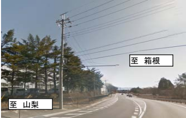
R138 須走電線共同溝
