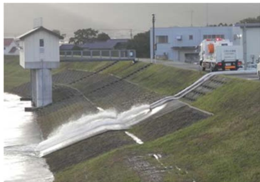
近年の排水ポンプ車稼働実績 (H29: 台風21号(函南町新田地区))
