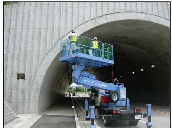
高所作業車によるトンネル点検
