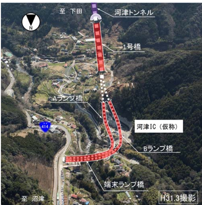
かわづ 河津IC（仮称）付近
