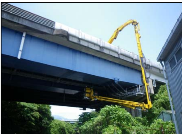
橋梁点検車による点検
