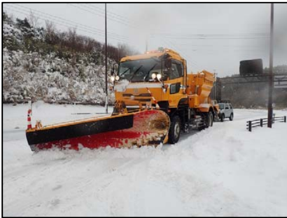
除雪作業(国道1号)
