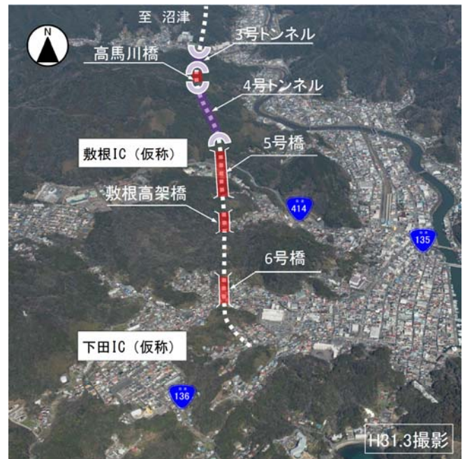
しもだ 下田IC（仮称）付近
