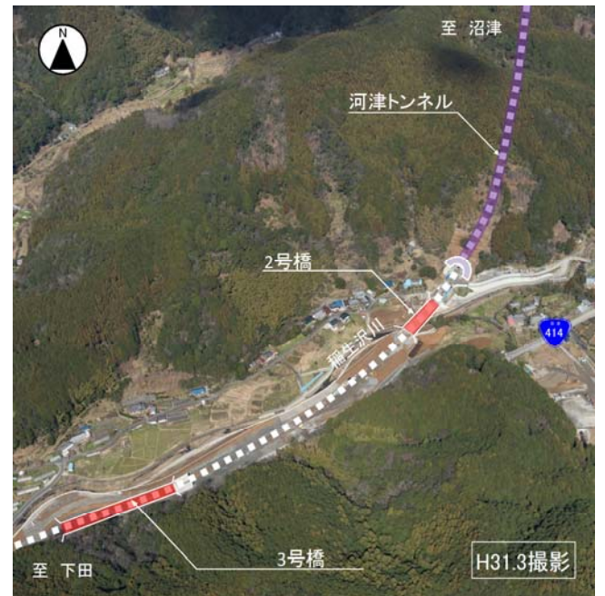
さかさかわ 逆川IC（仮称）付近
