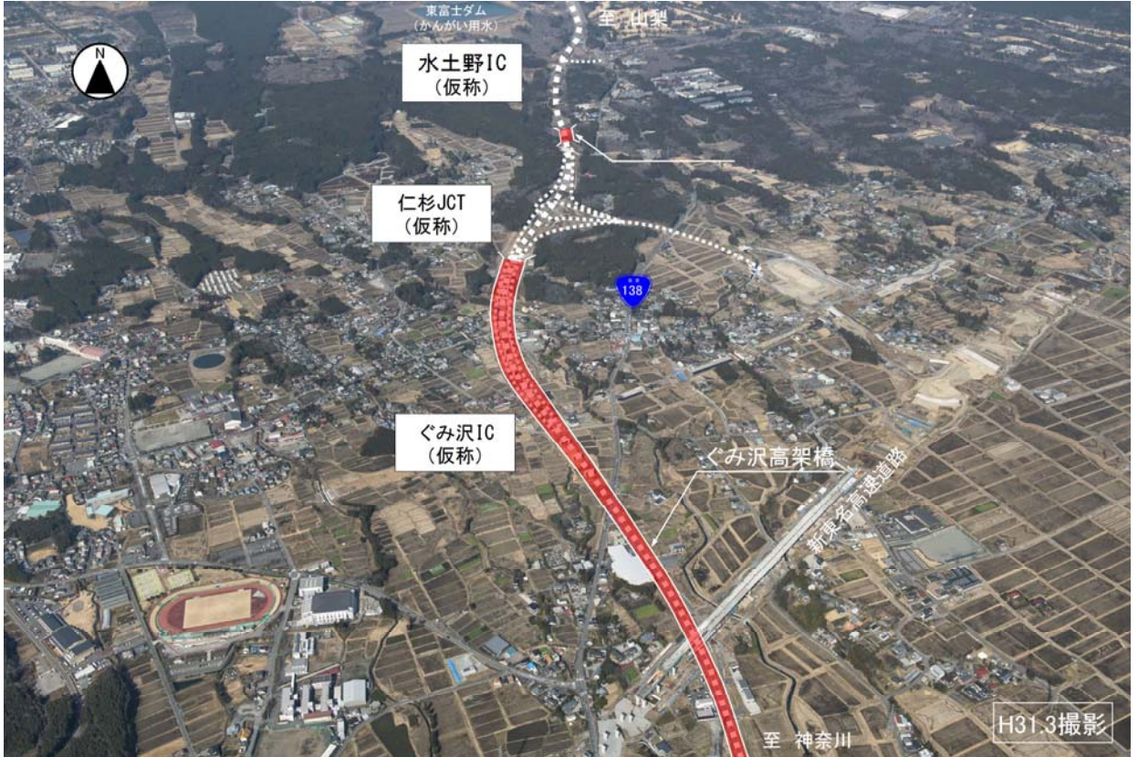
国道 138 号 すばしり 須走道路・ こてんぼ 御殿場バイパス (西区間) の状況写真
