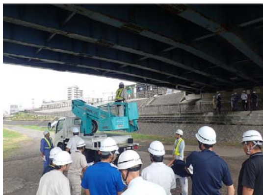
自治体向け橋梁点検研修(現地実習)
