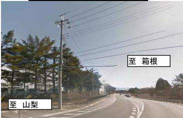
R138 須走電線共同溝
