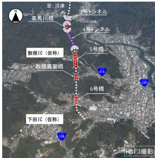
しもだ 下田IC（仮称）付近
