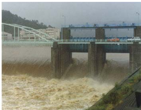
放水路分流堰の放流状況
