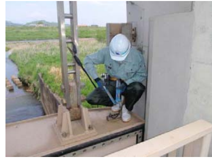
樋管ゲートの点検
