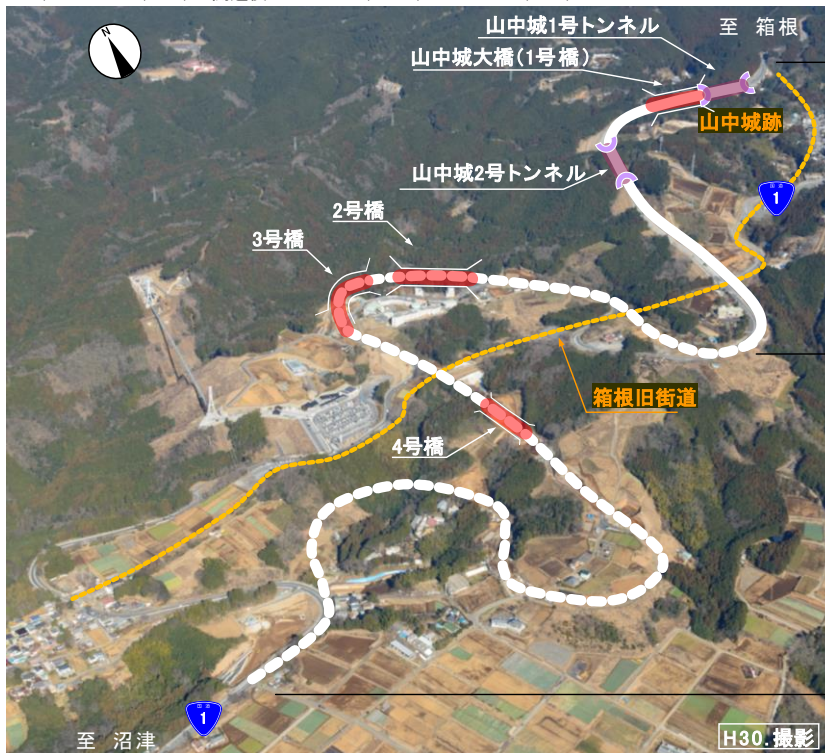
国道1号 笹原山中バイパスの状況写真
