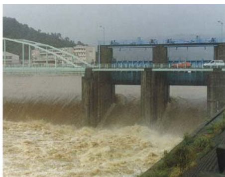
放水路分流堰の放流状況
