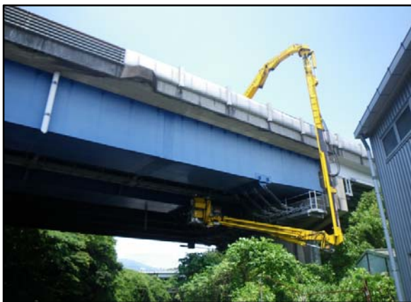
橋梁点検車による点検
