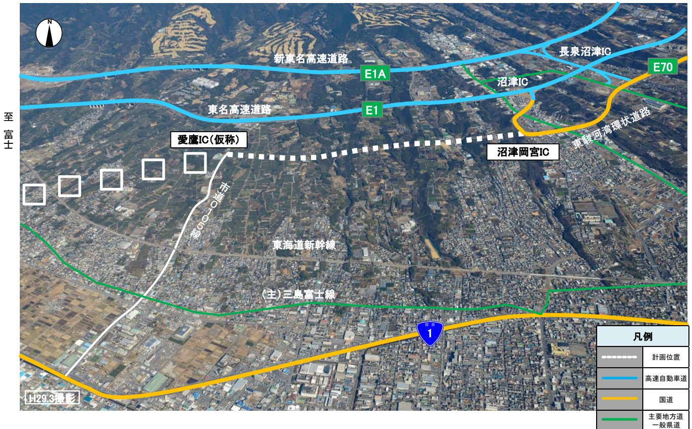
国道1号 東駿河湾環状道路 (沼津岡宮IC～愛鷹IC (仮称)) の状況写真
