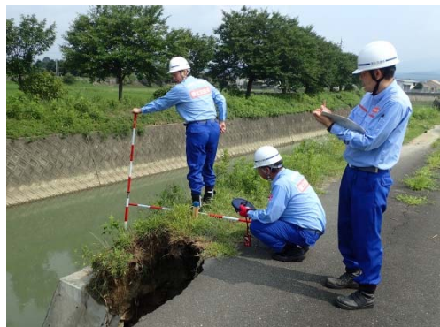
現地調査の様子(H29九州北部豪雨)
