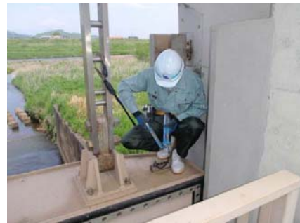
樋管ゲートの点検
