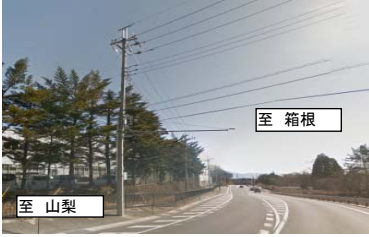
R138 須走電線共同溝
