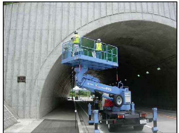
高所作業車によるトンネル点検
