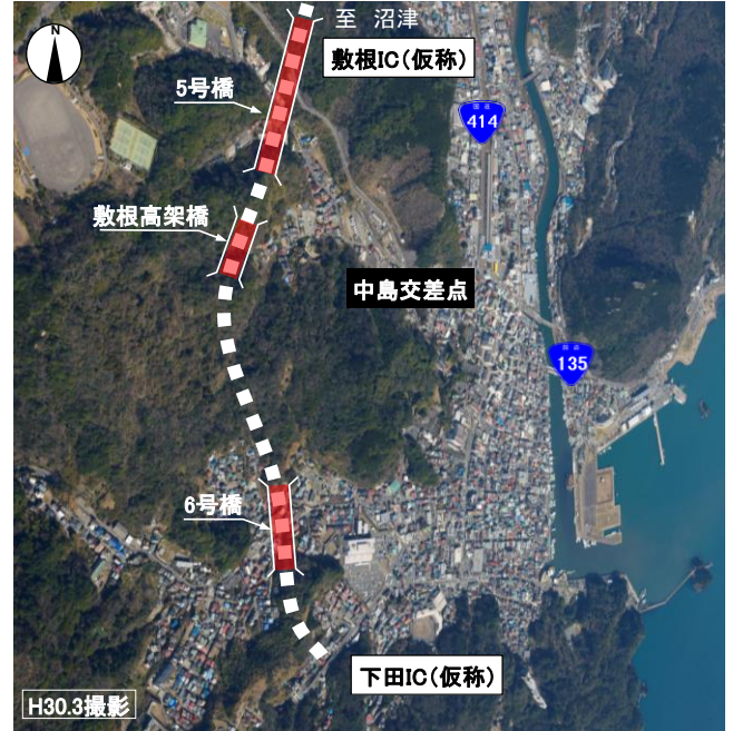
しもだ 下田IC（仮称）付近
