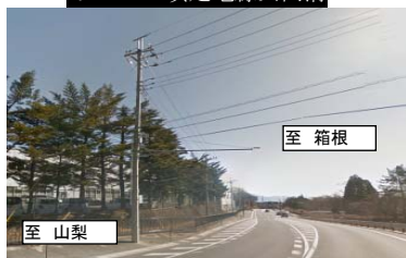
R138 須走電線共同溝
