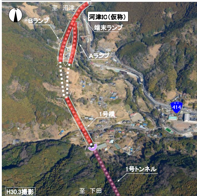
かわづ 河津IC（仮称）付近
