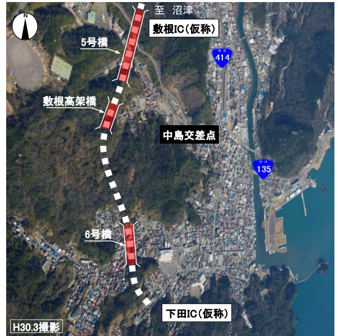
しもだ 下田IC（仮称）付近
