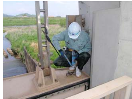
樋管ゲートの点検
