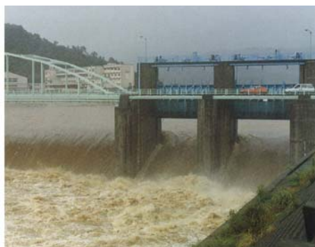
放水路分流堰の放流状況
