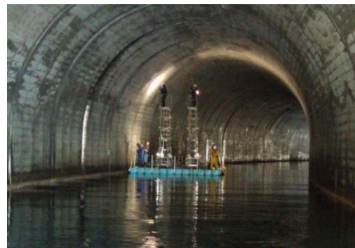
狩野川放水路口野トンネルの点検調査
