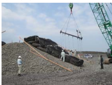
陸上試験施工状況 (H25 施工)
