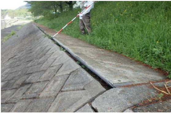
河川の巡視（雨裂箇所計測）
