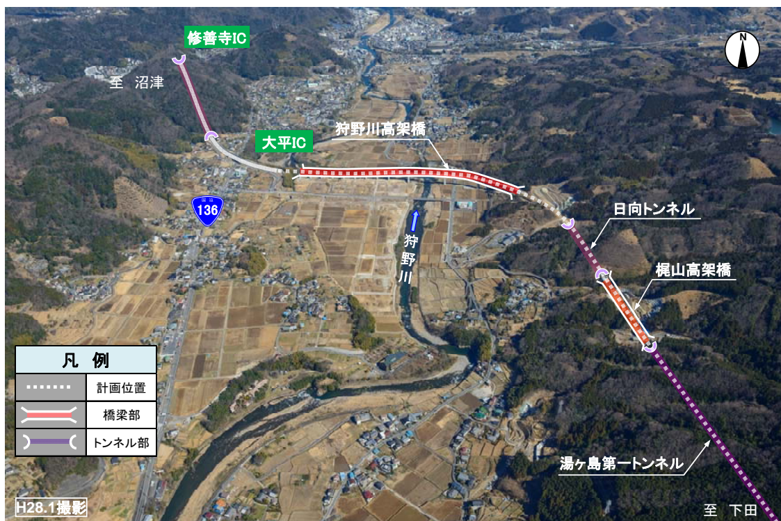
国道414号天城北道路（大平IC付近）の状況写真
