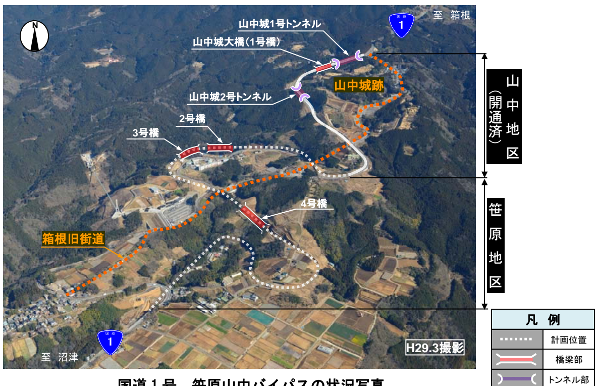
国道1号 笹原山中バイパスの状況写真
