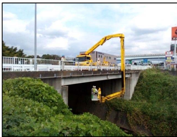
橋梁点検車による点検
