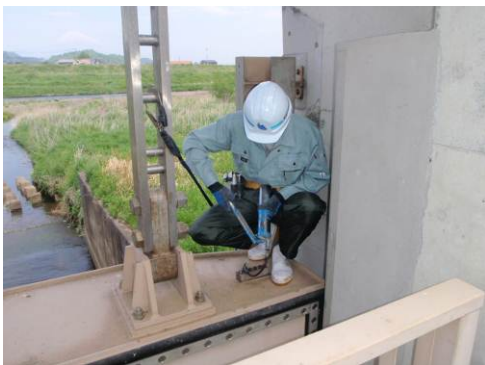
樋管ゲートの点検
