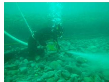
潜水作業 (マウンド材敷均し)
