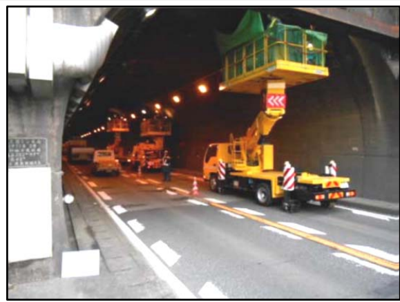
高所作業車によるトンネル点検
