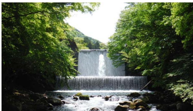
狩野川上流域で土砂生産・流出を調節する「本谷第3砂防堰堤」
