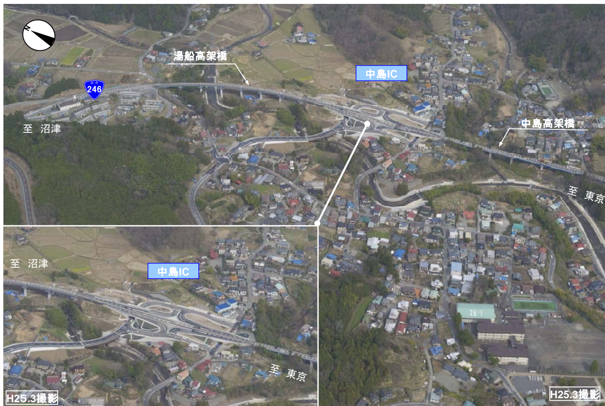
国道 246 号 裾野バイパス (中島 IC 付近) の状況写真
