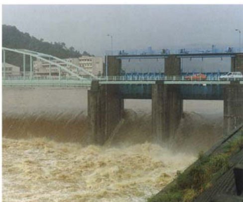
放水路分流堰の放流状況
