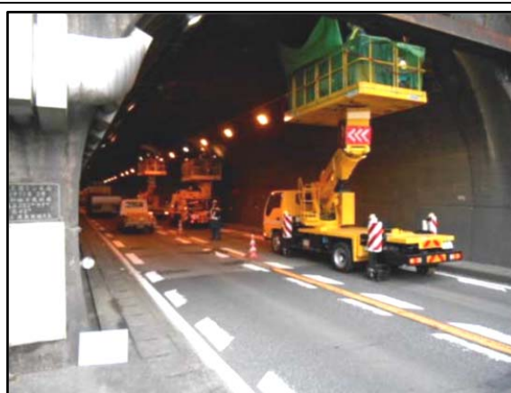
高所作業車によるトンネル点検
