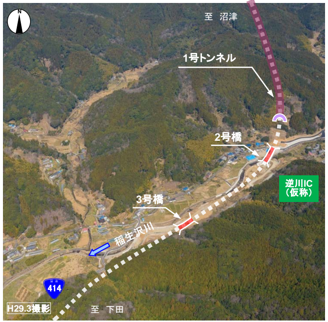
逆川 IC（仮称）付近
