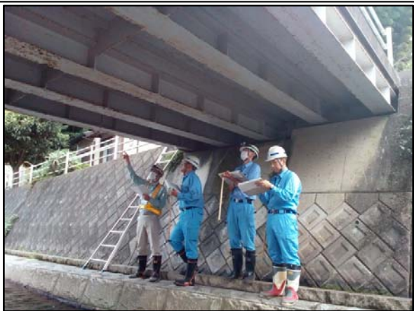
自治体向け橋梁点検研修(現地実習)
