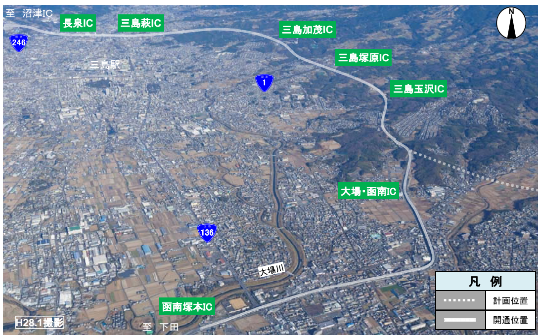
国道1号 東駿河湾環状道路の状況写真
