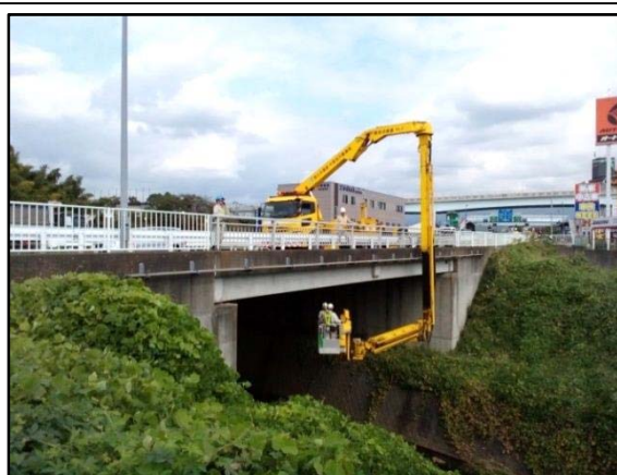
橋梁点検車による点検
