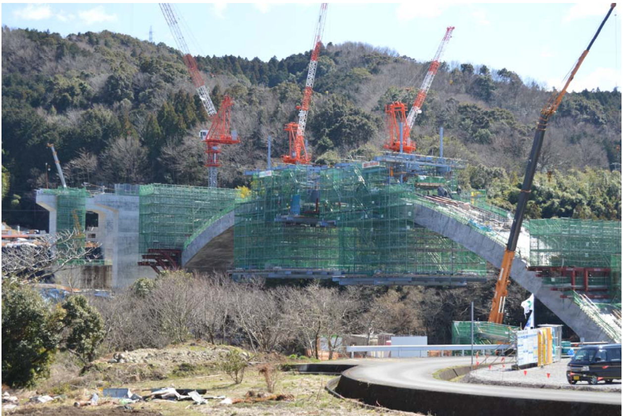
天城北道路 狩野川横断高架橋
