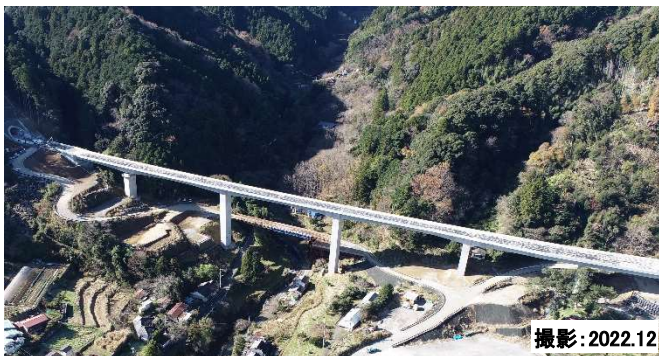
かわづ こなべ ばし 【河津小鍋橋】
