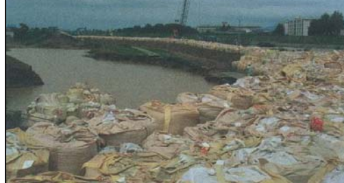
堤防決壊部応急仮締切
