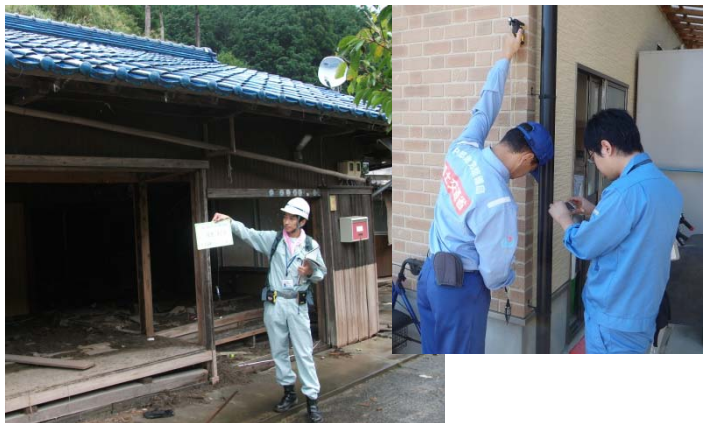
一般家屋の被災状況も隊員が調査します。
