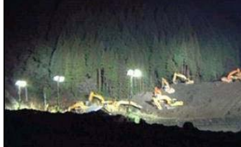
照明車による照明
