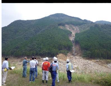
崩落危険箇所の調査
