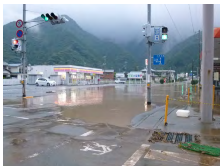
国道136号での浸水被害 宇久須地区
