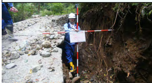
(調査状況：浜川流域③)
