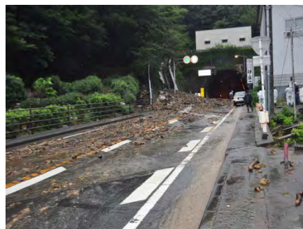
国道136号での土砂流出 宇久須地区
