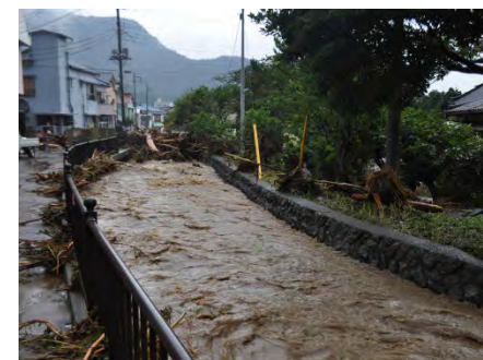
河川被害状況 安良里地区浜川
