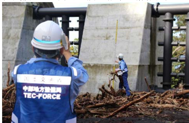
砂防堰堤の損傷や土砂・流木の堆積量を調査
