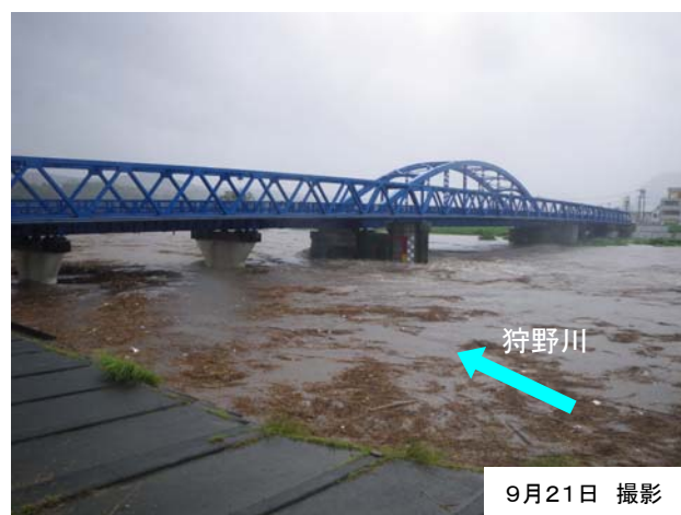
台風15号による出水状況
