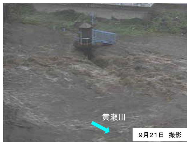
台風15号による出水状況
