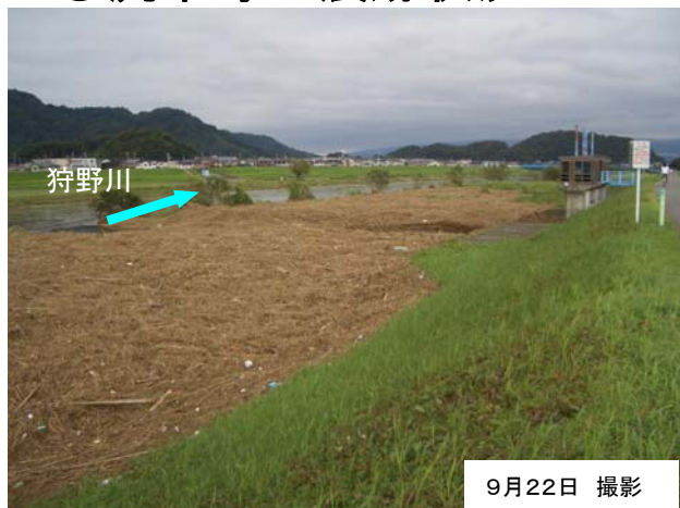
流木の痕跡状況(境川排水樋管)
