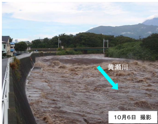
台風第18号による出水状況
