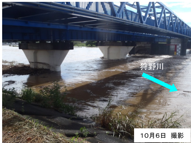
台風第18号による出水状況
