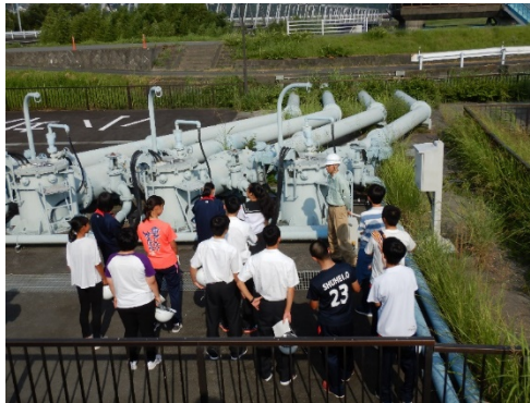
小坂排水機場の機能を学ぶ
