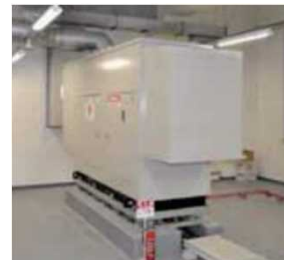
非常用発電設備のイメージ
