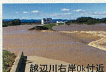
越辺川右岸0k付近
