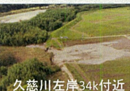
久慈川左岸34k付近
