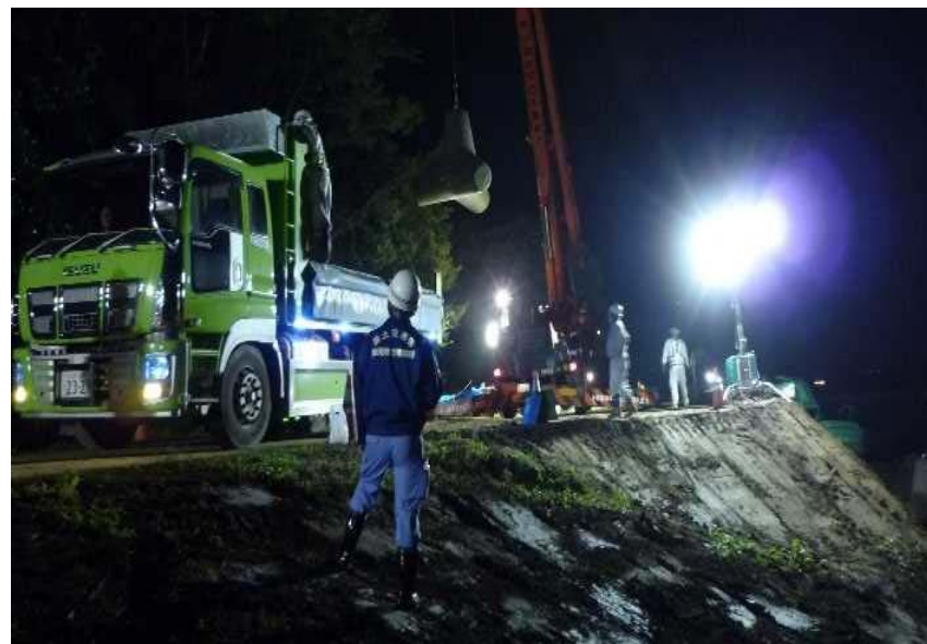
堤防復旧 (平成27年9月 関東・東北豪雨)
