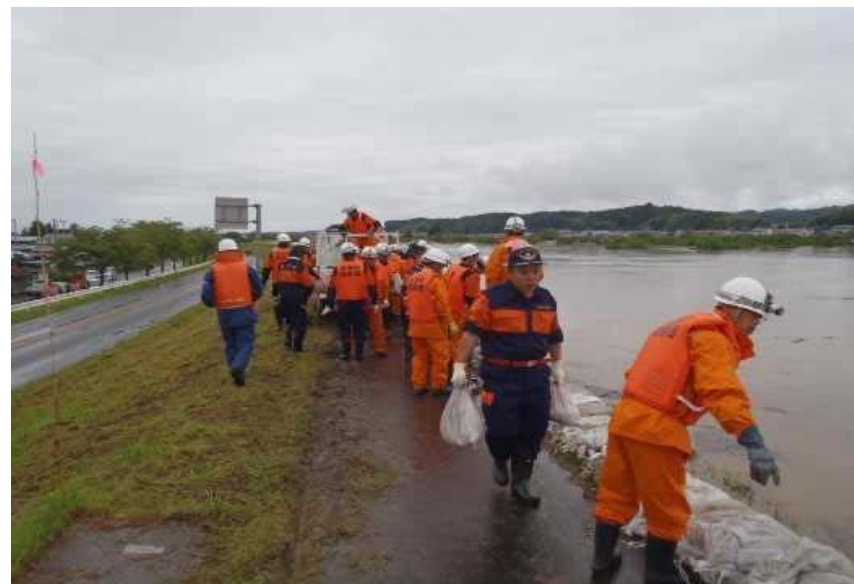
水防活動(積み土のう工法) (平成27年9月 関東・東北豪雨)
