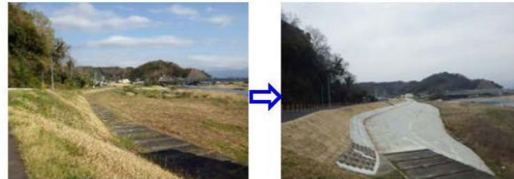
改修前(伊豆の国市 小坂地区)
