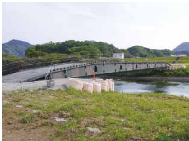
自衛隊 仮設橋 (07式機動支援橋)
