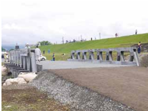
国土交通省 応急組立橋
