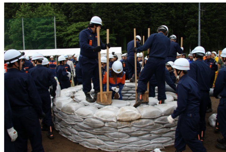
釜段工法の作成指導
