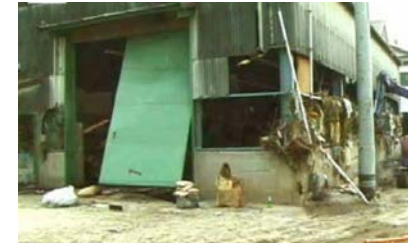
洪水流で破壊された工場 (平成12年9月東海豪雨(名古屋市西区))
