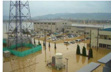
事業所の浸水状況 (平成16年7月新潟・福島豪雨(三条市))
