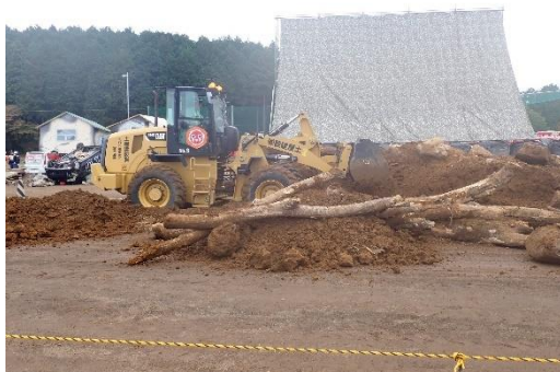
重機による土砂の除去
