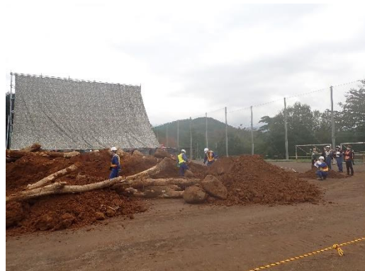
啓開後のパトロールによる安全性の確認
