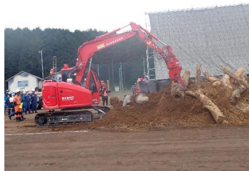
重機による倒木の除去
