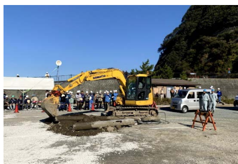
倒壊電柱の撤去
