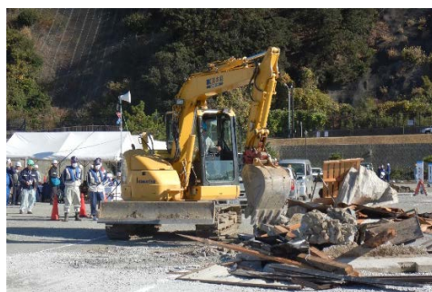
重機による瓦礫の除去
