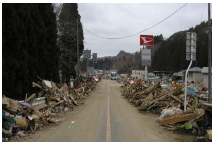
道路啓開完了後の状況
