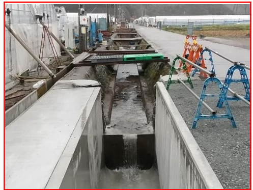
洞川河道拡幅(市)
