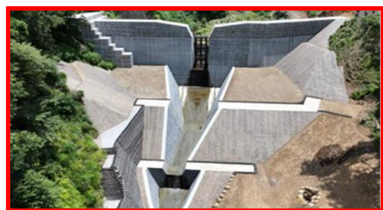
砂防施設等の整備イメージ（工事中）
