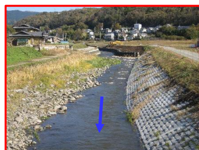
来光川堤防整備・護岸整備(県)
