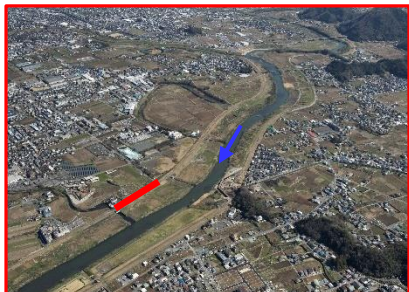
狩野川堤防整備(国)
