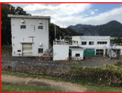
大平徳倉排水機場のポンプ遠隔操作装置等の導入(県)
