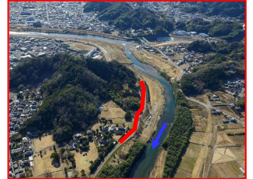
狩野川堤防整備(国)
