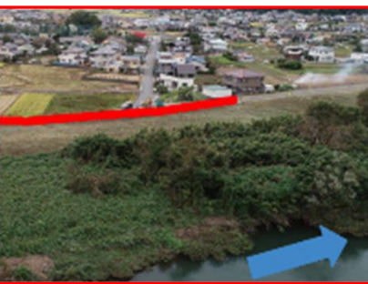
狩野川堤防整備(国)
