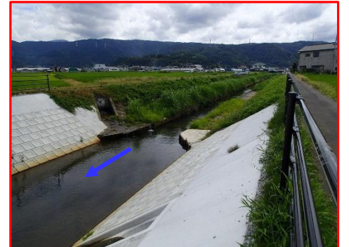
堂川河道拡幅(県)
