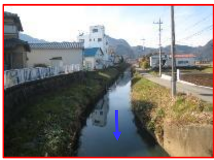
大平江川河道拡幅・護岸整備(市)
