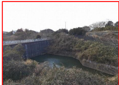
錦が丘調整池堆積土砂の掘削(市)
