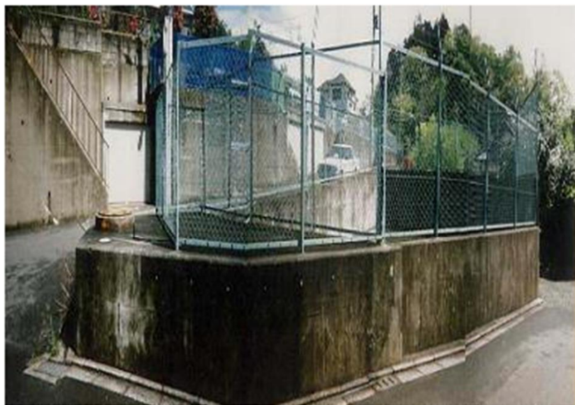
従前の防災調整池
