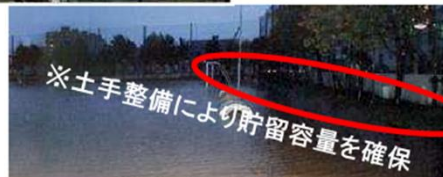
【校庭を活用した貯留施設】
