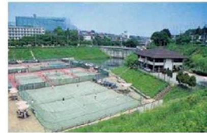
雨水貯留浸透施設の例(防災調整池)
