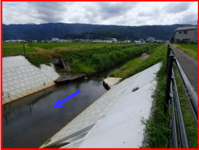
堂川河道拡幅(県)
