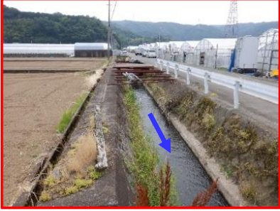
洞川河道拡幅(市)
