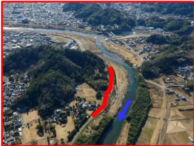
狩野川堤防整備(国)
