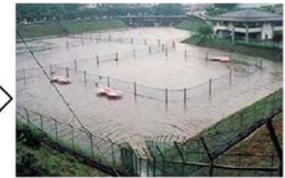
雨水貯留浸透施設の例(防災調整池)
