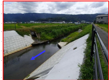
堂川河道拡幅（県）
