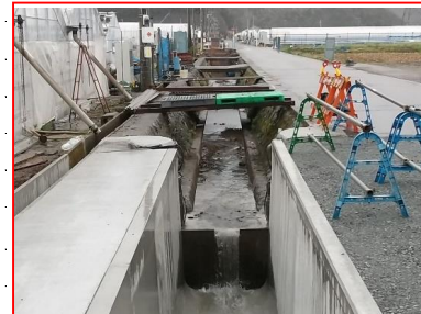
洞川河道拡幅（市）
