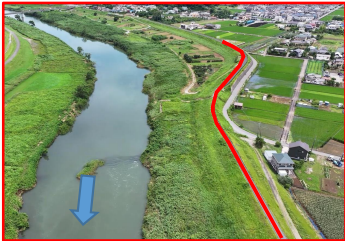
狩野川堤防整備(国)
