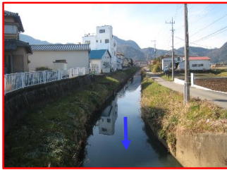
大平江川河道拡幅・護岸整備(市)
