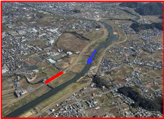
狩野川堤防整備(国)
