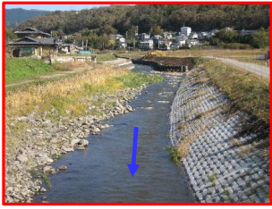
来光川堤防整備・護岸整備(県)
