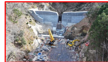
砂防施設等の整備イメージ（工事中）
