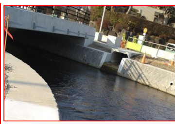
境川河道拡幅・護岸整備(県)
