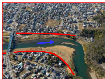
狩野川堤防整備(国)
