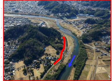
狩野川堤防整備（国）
