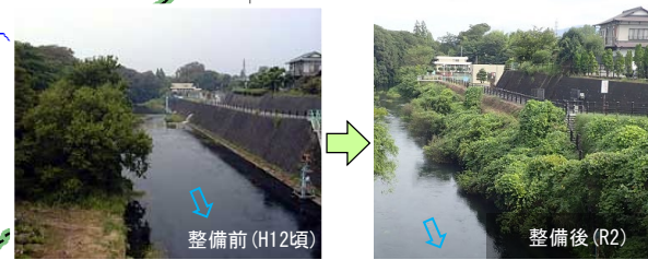
生物に配慮した多自然護岸整備
