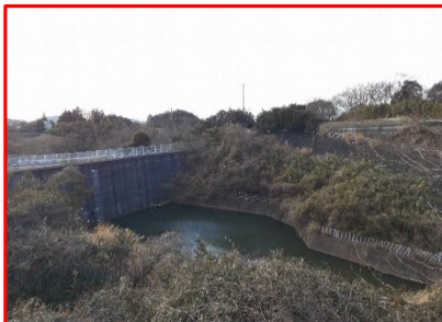
錦が丘調整池堆積土砂の掘削(市)
