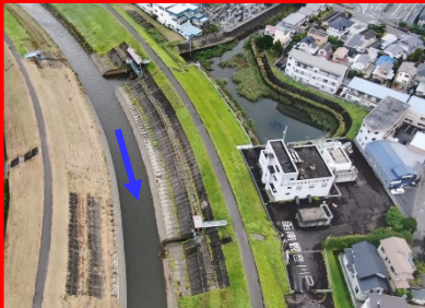
函南観音川排水機場の遠隔制御化(国)
