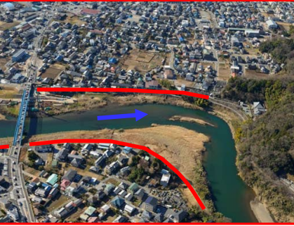
狩野川堤防整備(国)
