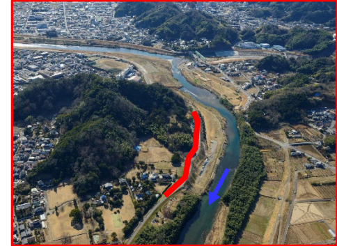
狩野川堤防整備(国)
