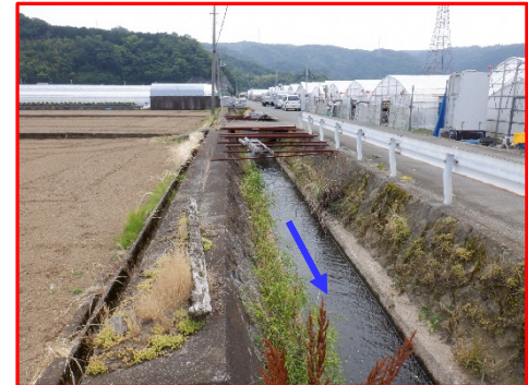
洞川河道拡幅(市)
