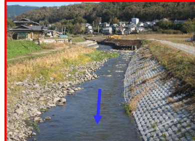
来光川堤防整備・護岸整備(県)
