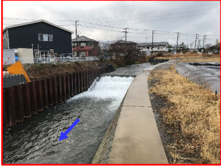
境川河道拡幅・護岸整備(県)
