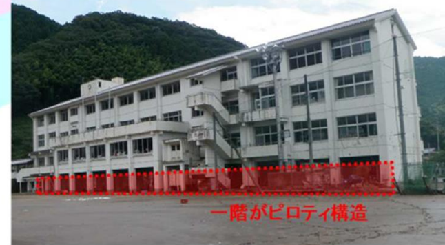
ピロティ構造の事例
