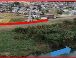
狩野川堤防整備(国)
