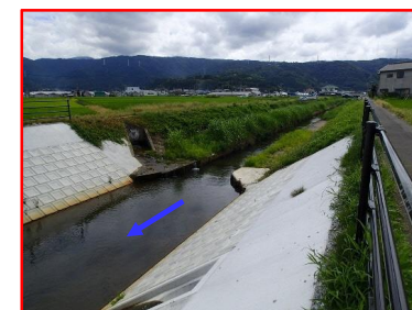
堂川河道拡幅（県）
