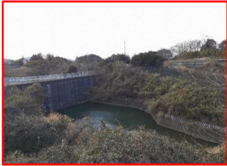
錦が丘調整池堆積土砂の掘削(市)
