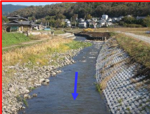
来光川堤防整備・護岸整備(県)
