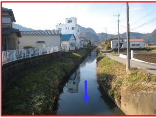
大平江川河道拡幅・護岸整備(市)
