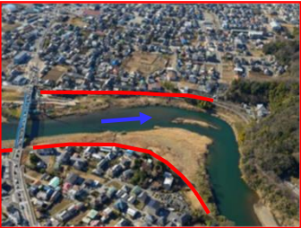
狩野川堤防整備(国)
