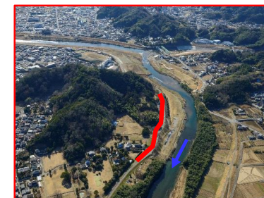
狩野川堤防整備（国）
