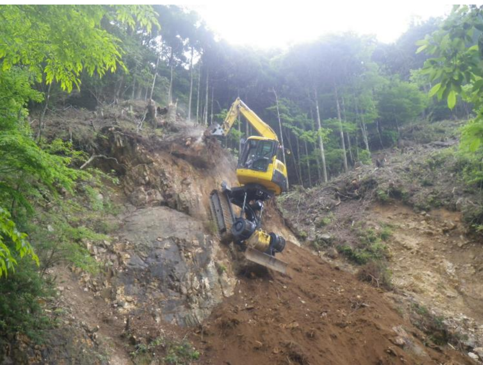
高所掘削機械による不安定土砂取り除き
