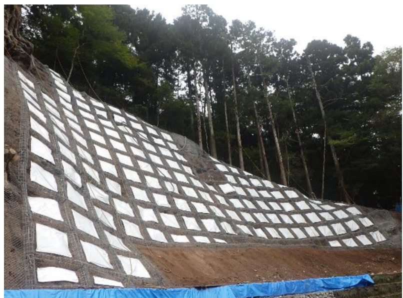
山腹工事施工中の様子
