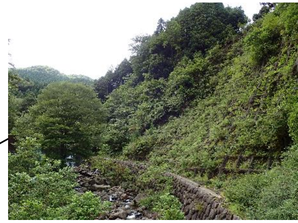
・巨石積護岸工と山腹工の緑化（猫越川左岸）
