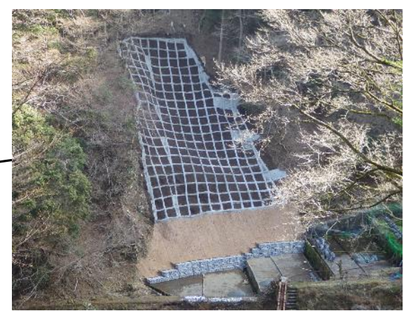
・狭隘箇所の山腹工の緑化(R3施工長野川右岸)
