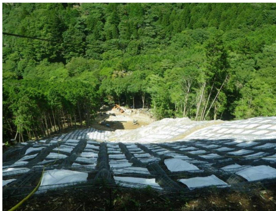
-7- 2022.8月現在 法砕工を施工中
