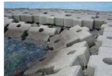
突堤の被覆ブロックの散乱事例
