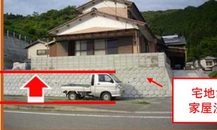
霞堤からの流水により浸水しているが宅地嵩上げにより家屋浸水は大幅に低減!
