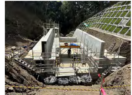
井戸川雨水貯留池
