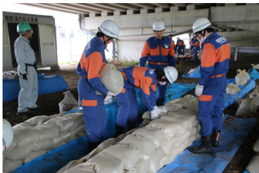
土のう積み工法
