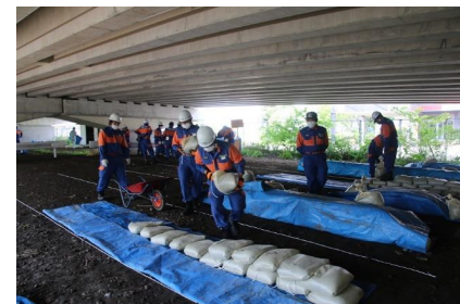
土のう積み工法
