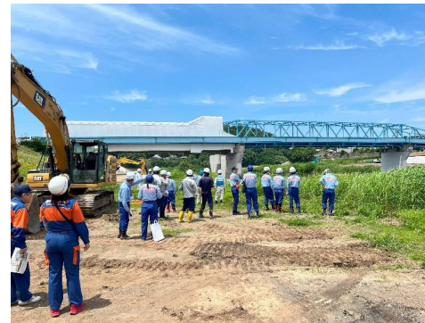
清水町徳倉橋下流(狩野川左岸)
