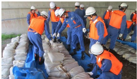
土のう積み工法
