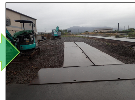
駿東地区ストックヤード整備状況（整備中）
