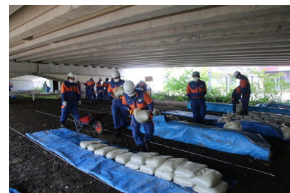
土のう積み工法
