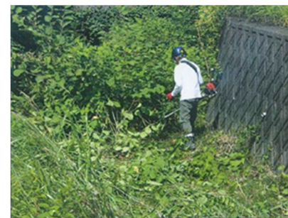
除草作業中①
