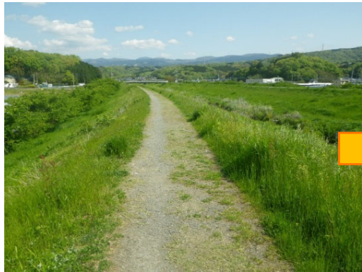
柿沢川施工前
