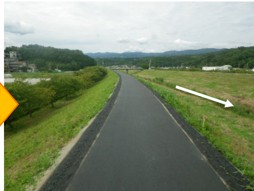
柿沢川堤防天端舗装後
