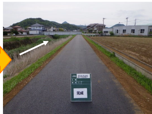
葦山古川堤防天端舗装後
