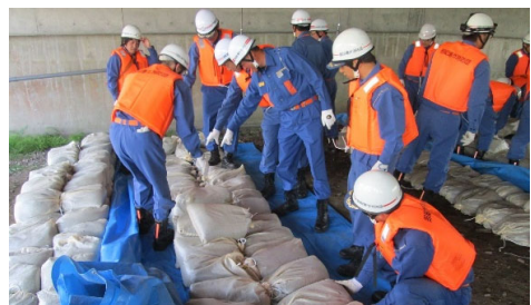
土のう積み工法
