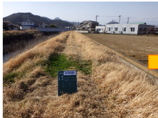
葦山古川施工前
